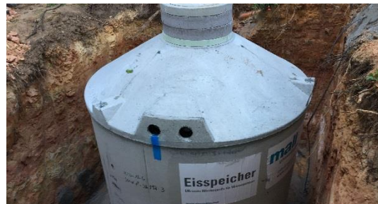
Abbildung 3: Eisspeicher vor der Verfüllung im Erdreich neben dem Demonstrator
