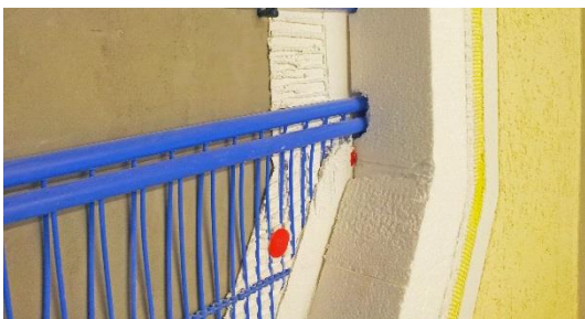
Abbildung 1: Detailaufnahme einer Musterwand der außenliegenden Wandtemperierung
